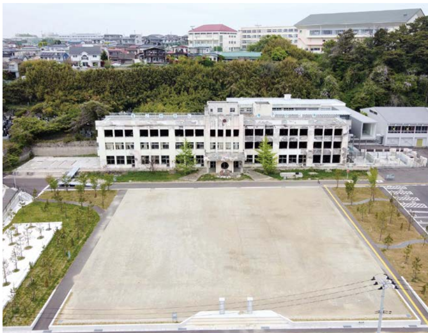
石巻市震災遺構 門脇小学校
